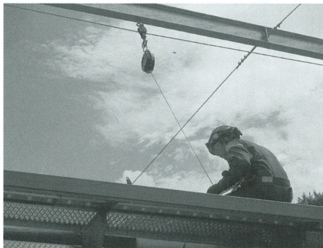
セーフティブロックの建設。安全対策は最重要事項だ。
